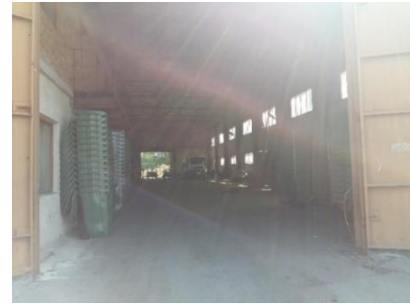
Фото. Сервісне приміщення
