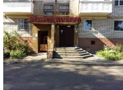
Фото. Відсутність урн біля входу будинку
