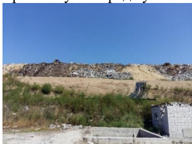
Фото. Обладнання для відводу біогазу
