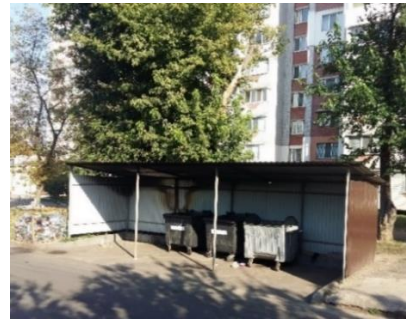
Фото. Облаштований майданчик з контейнером для ПЕТ-відходів
