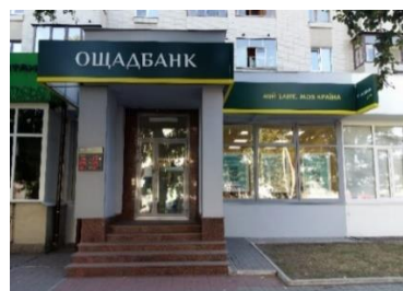
Фото. Відсутність урн біля будівель установ та організацій
