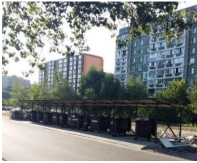
Фото. Контейнерний майданчик з сітчастим огороженням та накриттям
